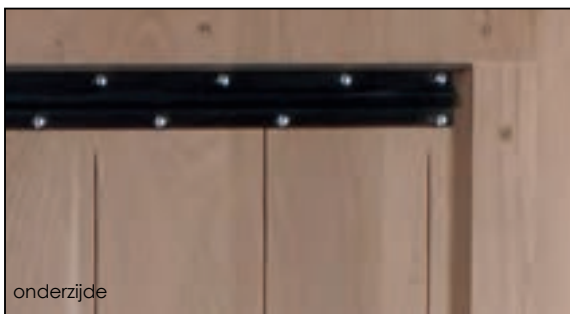
Staalprofielen en ontlastingsleuven
